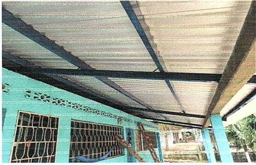
Foto 1: Se realizó sustitución de techo de madera por estructura de metal en corredor del módulo 1.
