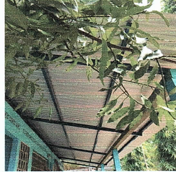
Foto 2: Se realizó sustitución de techo de madera por estructura de metal en corredor del módulo 1.
