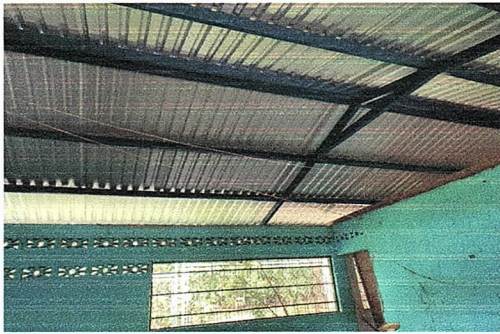
Foto 3: Se realizó sustitución de techo de madera por estructura de metal en las aulas del módulo 1.
