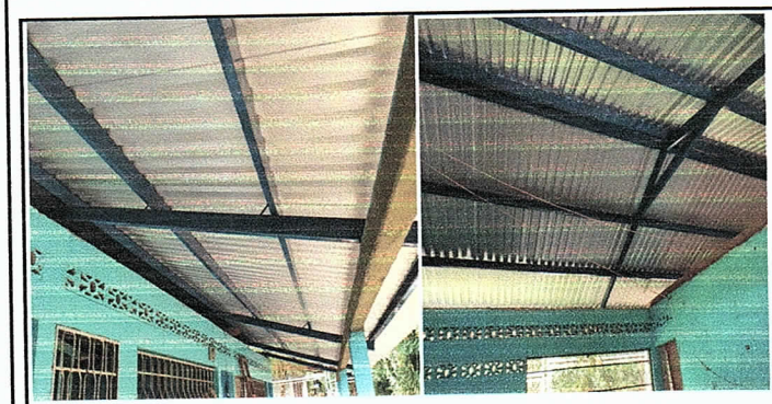
Foto 5: Sustitución de estructura de madera por metálica en el módulo 1 contruido en 1980.
